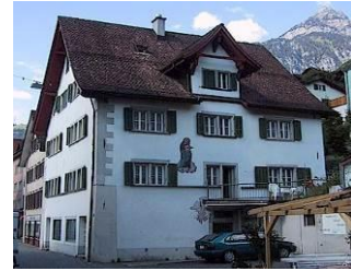
Mehrfamilienhaus Rämi-Haus 6454 Flüelen
