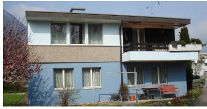
Einfamilienhaus Sportplatzweg 6440 Brunnen
