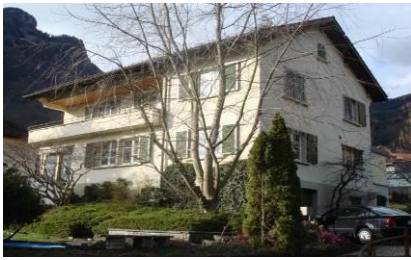
Einfamilienhaus Stückistrasse 6442 Gersau
