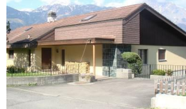
Einfamilienhaus Bustistrasse 6467 Schattdorf
