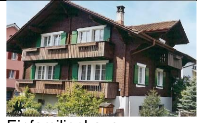
Einfamilienhaus Blumenfeldgasse 6460 Altdorf
