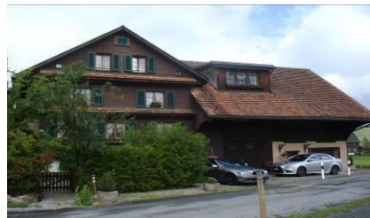
Bauern- / Gadenhaus Wäni 8840 Einsiedeln
