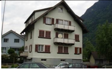
Mehrfamilienhaus Seedorferstrasse 6460 Altdorf
