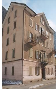
MFH Gotthardstrasse 6472 Erstfeld
