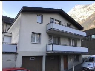
Mehrfamilienhaus Lindenstrasse 6472 Erstfeld
