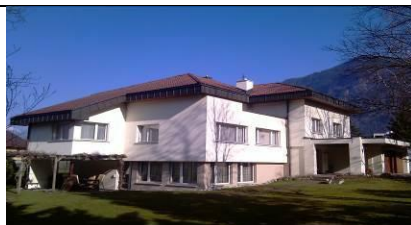
Liebhaberobjekt Rüttistrasse 6467 Schattdorf
