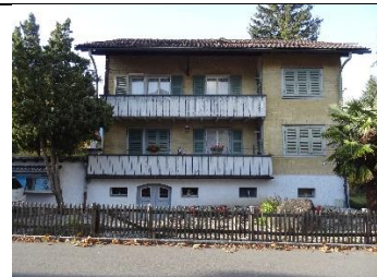
Mehrfamilienhaus Besslerweg, 6460 Altdorf
