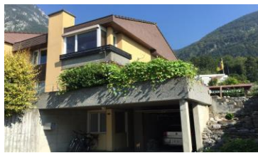
Doppeleinfamilienhaus Höhenweg 6454 Flüelen
