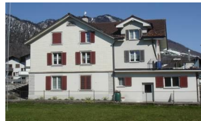
Mehrfamilienhaus Schwyzerstrasse 6440 Brunnen
