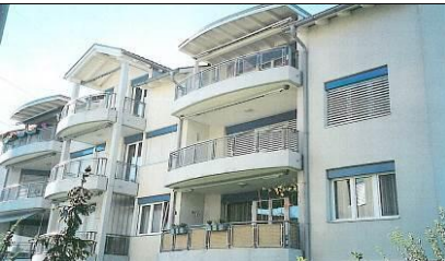
Mehrfamilienhaus Feldmatte 6206 Neuenkirch
