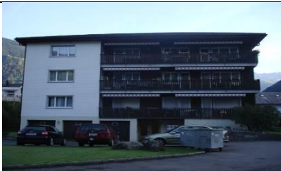
Mehrfamilienhaus Gandrütti 6467 Schattdorf
