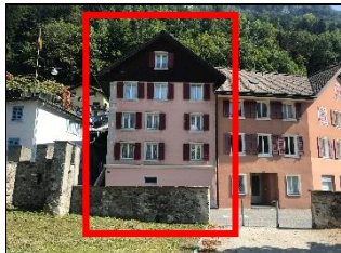
Zweifamilienhaus Dorfstrasse 6454 Flüelen
