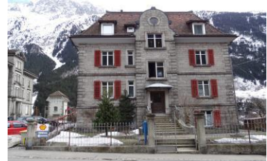
Mehrfamilienhaus Gotthardstrasse 6487 Wassen
