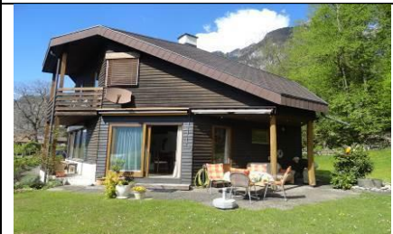
Einfamilienhaus Höhenstrasse 6454 Flüelen
