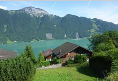
Einfamilienhaus Buechistrasse 6377 Seelisberg
