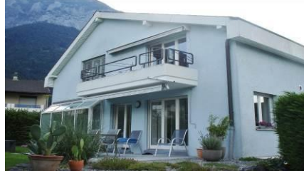
Einfamilienhaus Blumenfeldstrasse 6462 Seedorf
