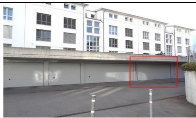
Doppelgarage Bahnhofplatz 6440 Brunnen
