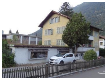
Mehrfamilienhaus Besslerweg 6460 Altdorf
