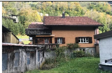
Zweifamilienhaus Ribl 6465 Unterschächen
