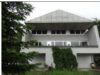
Einfamilienhaus Bustistrasse 6467 Schattdorf
