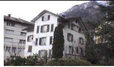
Mehrfamilienhaus Dorfstrasse 6452 Sisikon
